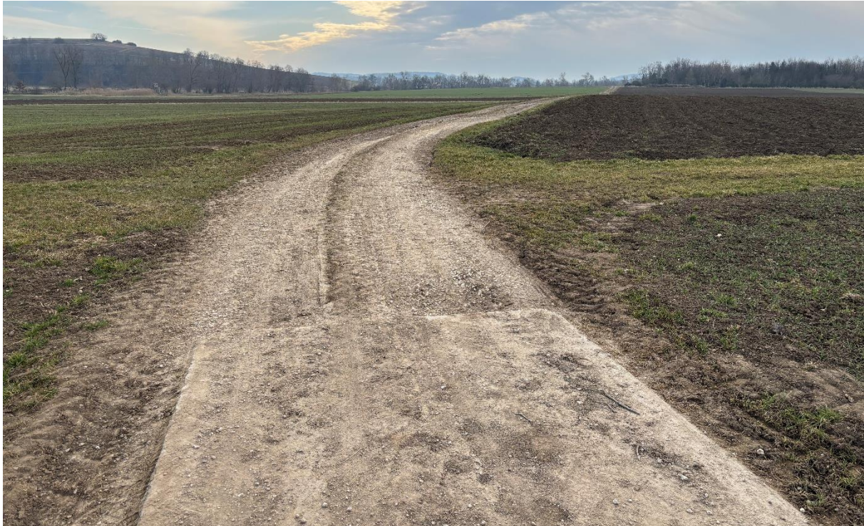
Abbildung 14: Übergang der Wegebefestigung (Betonplatten) in Schotter am nordwestlichen Ende des untersuchten Abschnitts des Ersatzwegs BÜ Enkingen I - BÜ "Mühle", Blickrichtung W nach E
